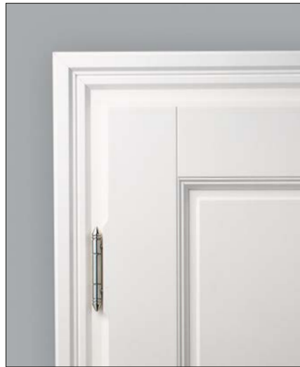
Der Falz und die Profilfräsung
